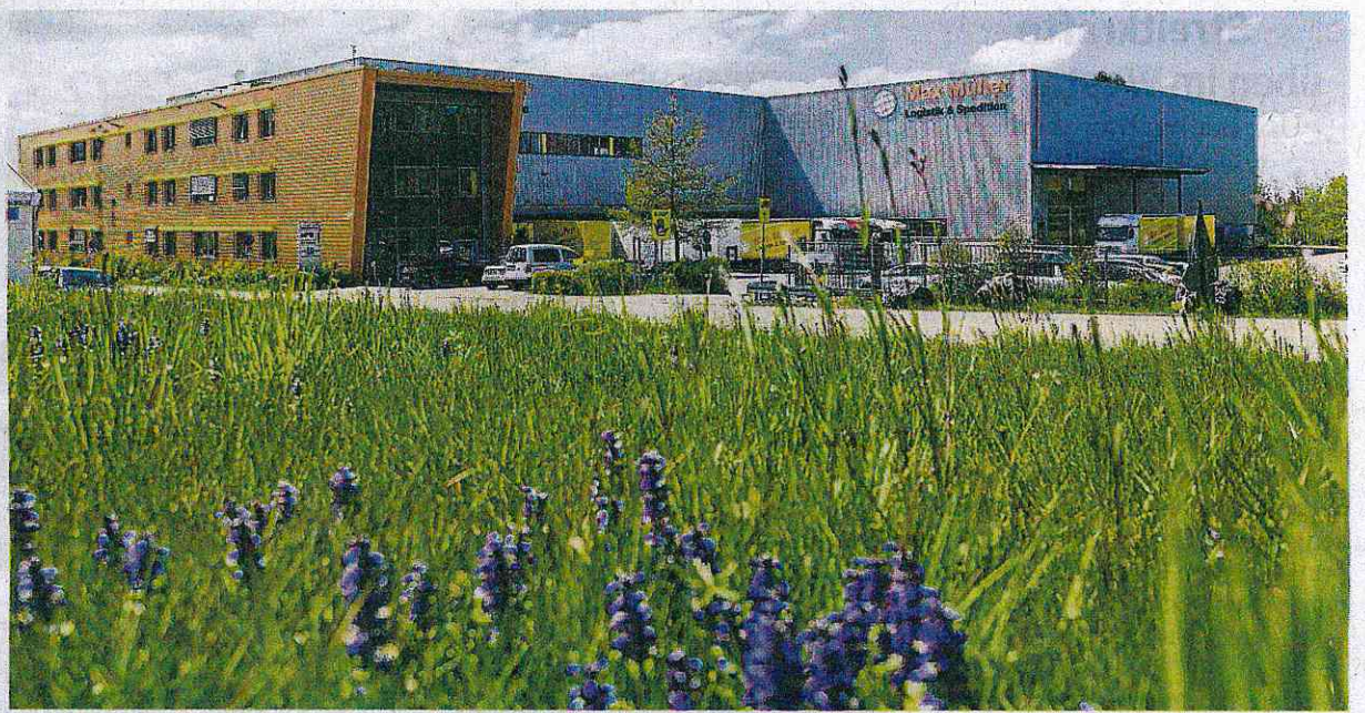
Auf dem Firmensitz in Opfenbach hat das Unternehmen aktuell eine PV-Anlage errichtet. Sie soll 218.000 Kilowattstunden im Jahr Ertrag bringen. Fotos: Trautmann fotografie
